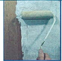
鉄板型枠面 合板型枠面に ローラーにて塗布
